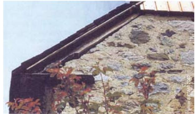
[fig. 59] - Désolidarisation du toit et du mur en maçonnerie d'une vieille maison attenante à l'église de Salles-Argeles
