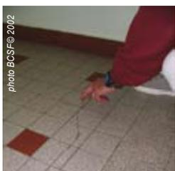
[fig. 83] - Fissures sur sol et murs (Lycée Colbert - Lorient)
