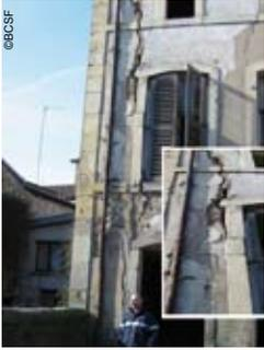
(photo 41) - Rambervillers (départ. 88) - Elargissement d'une fissuration sur bâtiment en cours de démolition.
