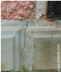
Fig.18 - Estaing fissure aux angles d'une fenêtre sur une vieille maison
