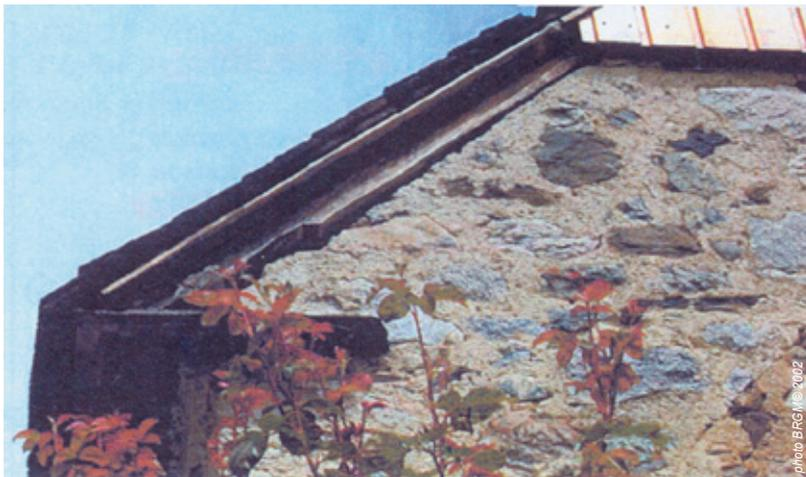
Fig.12 - Désolidarisation du toit et du mur en maçonnerie d'une vieille maison attenante à l'église de Salles-Argelès
