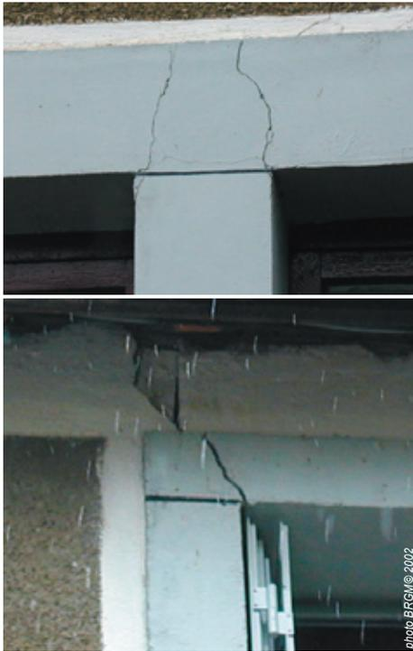
Fig.16 - Arrens, fissures aux angles des fenêtres sur une vieille maison d'Arrens
