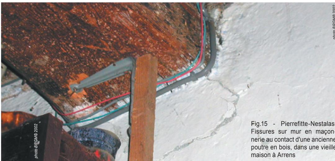
Fig.15 - Pierrefitte-Nestalas, Fissures sur mur en maçonnerie au contact d'une ancienne poutre en bois, dans une vieille maison à Arrens
