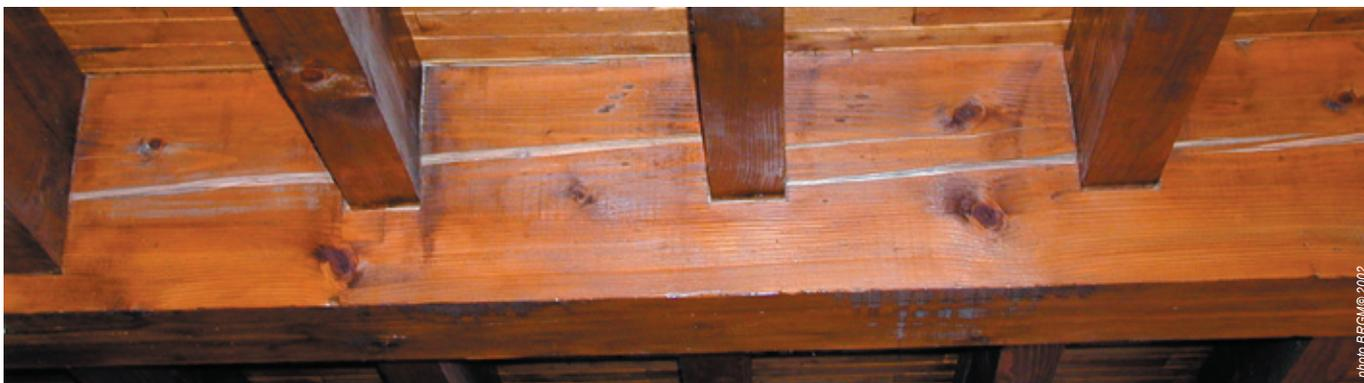
Fig.13 - Pierrefitte-Nestalas, fissures préexistantes ayant été agrandies dans les poutres constituant une charpente en bois d'une maison datant d'avant 1789
