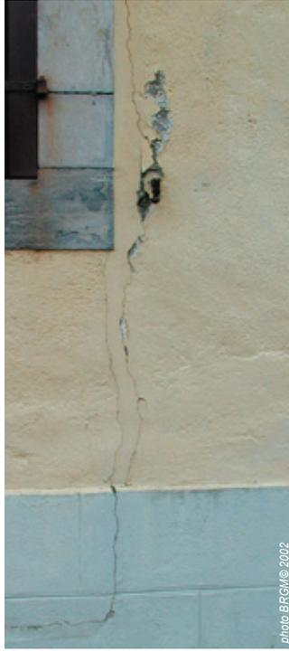
Fig.17 - Arrens, fissures préexistantes agrandies lors du séisme sur le mur d'une maison d'Arrens
