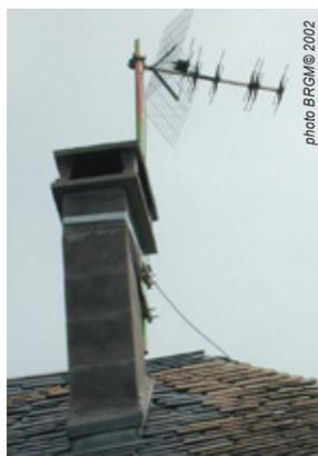
Fig.10 - Cheminée ébranlée et support de l'antenne déformée sur une vieille maison en maçonnerie attenante à l'église de Salle-Argelès
