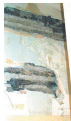
Fig.9 - Chute d'un cumulus ayant arraché le plâtre du mur et laissant apparaître la structure du bâti d'une maison particulière à Cauterets
