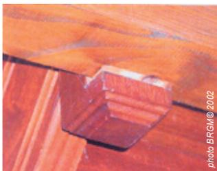
Fig.14 - Pierrefitte-Nestalas, poutre en bois d'escalier désolidarisée de la charpente principale
