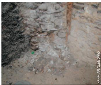
Fig.19 - Saint-Savin pilier en maçonnerie très ancienne écroulée à la base dans un grenier d'une vieille maison
