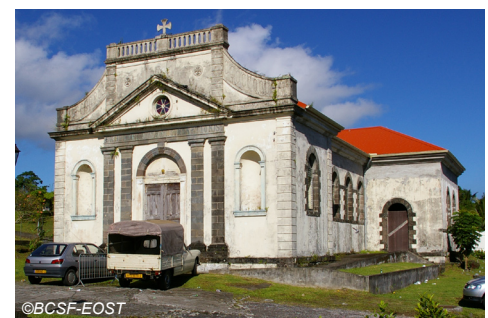
Fig. V-33 : Ajoupa-Bouillon - église (sans dégâts).
