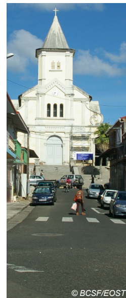
Fig. V-161 : St.-Esprit - Eglise (sans dégât).
