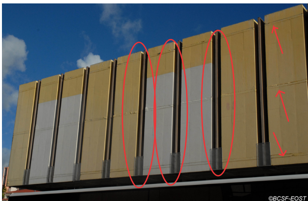
Fig. V-136 : Fort-de-France - Centre de tri (La Poste), fissures à la jonction dalle/murs (cercles = éléments de façade instables).
