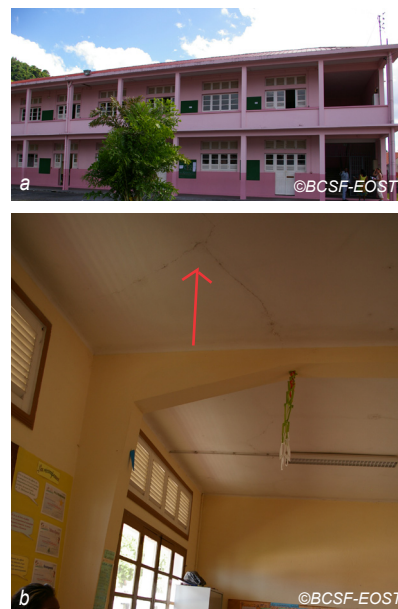
Fig. V-69 : St. Pierre - Ecole Philemont-Montout - fissure fine sur dalle plafond (rare dégât de niveau 1).
