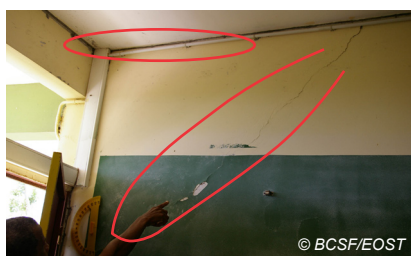
Fig. V-193 : Rivière Pilote - Collège Jacques Roumain - exemple de fissures traversantes sur voile de béton (Pré-existence ?) et traces de mouvement de la dalle.
