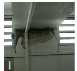
Fig. V-204 : Eclatement de béton de couverture.
