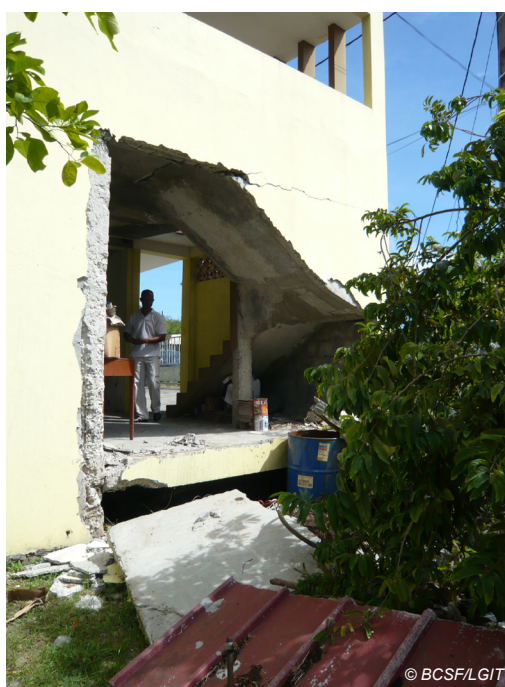
Fig. V 224 : Ferré, Sainte-Anne. La partie avale de la maison a commencé à glisser dans la pente.
