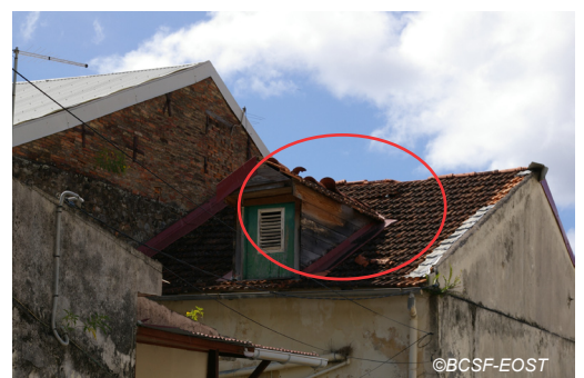
Fig. V-67 : Saint-Pierre centre - maison individuelle, chute de tuiles.
