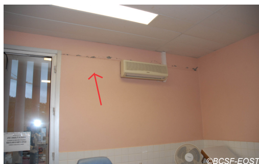
Fig. V-85 : La Trinité - (CH L.D), fissure horizontale.
