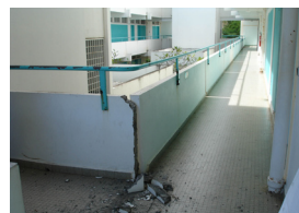
Fig. V-203 : Le Marin - Lycée Raymond Nérès, entrechoquement des garde corps, suite à l'oscillation des deux bâtiments).
