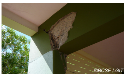
Fig. V-141 : Le Lamentin, école primaire des Roches Carrées.
