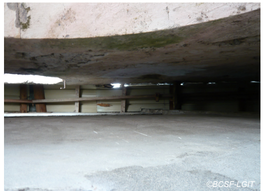
Fig. V-75 : Gros-Morne, détachement de la façade de l'église (prise de vue en contre-plongée).
