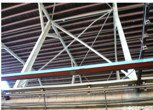
Fig. V-166 : Trois-Ilets, poterie, flambement d'une croix de St.-André dans les séchoirs.
