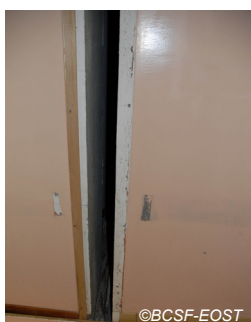
Fig. V-84 : La Trinité - (CH L.D), joint de dilatation.
