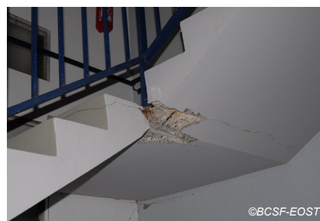
Fig. V-93 : La Trinité - Bâtiment H de l'AFPA - éclatement du béton de couverture par torsion de l'escalier.
