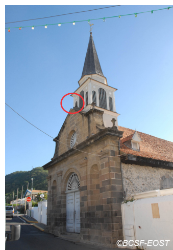
Fig. V-118 : Case-Pilote, église, chute d'une croix et de quelques tuiles.
