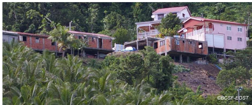
Fig. V-7 : Exemples de constructions vulnérables implantées sur un terrain en pente et comportant un niveau transparent
