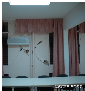
Fig. V-94 : La Trinité - Bâtiment H de l'AFPA - fissure large en X dans mur de remplissage.
