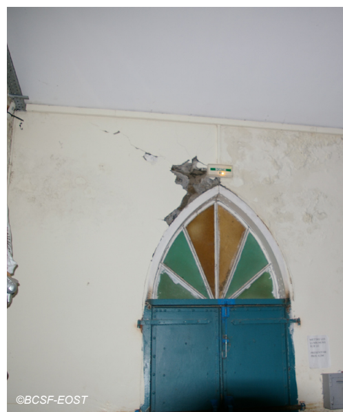
Fig. V-59 : Sainte-Marie, église Mornes des Esses (vue intérieure).
