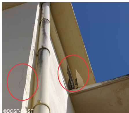
Fig. V-71 : St. Pierre - fissures et chute de mortier.
