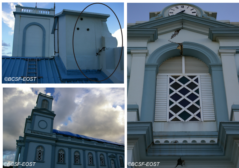
Fig. V-54 : Eglise de Sainte-Marie - fissuration large et traversante du fronton (mur en moellons).
