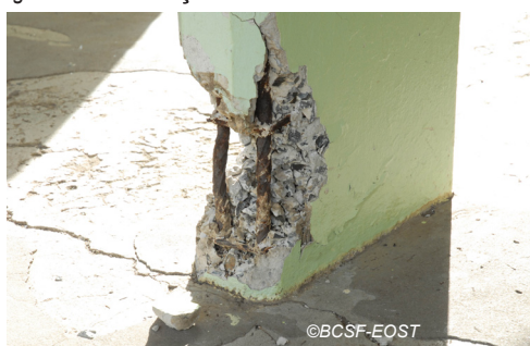
Fig. V-146 : Le François - Ecole Anne Marc - éclatement de mortier en pied de poteau et début de flambement des armatures.
