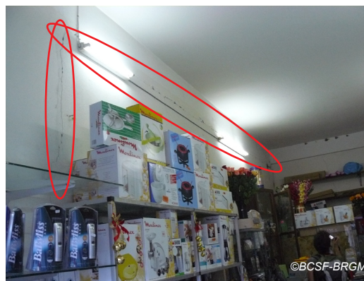
Fig. V-22 : Le Lorrain - Magasin ayant connu la chute d'objets et des fissures de niveau 2;
