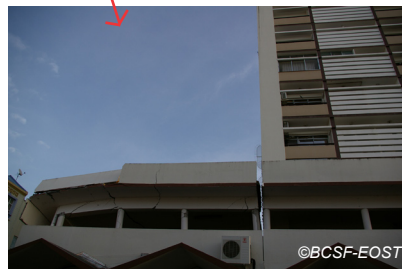
Fig. V-123 : Fort-de-France Immeuble Plein Ciel, façade sud.
