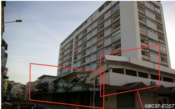
Fig. V-122 : Fort-de-France Immeuble Plein Ciel, façade ouest.
