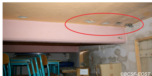
Fig. V-64 : Eclatement de béton suite à infiltration.
