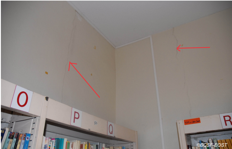
Fig. V-132 : Fort-de-France - Bibliothèque Schoelcher, fissures fines (partie récente).
