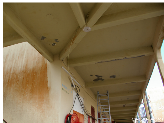
Fig. V-63 : Eclatement de béton (présence de corrosion).
