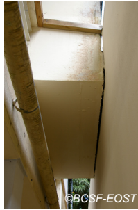
Fig. V-13 : Grand-Rivière - Ecole maternelle - décollement du bâtiment mitoyen.
