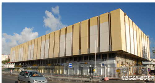
Fig. V-135 : Fort-de-France - Centre de tri (La Poste).
