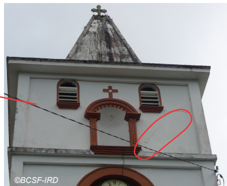
Fig. V-73 : Fonds-Saint-Denis Eglise - fissuration du clocher.
