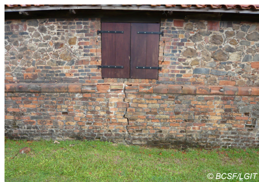
Fig. V-164 : Trois-Ilets, poterie, fissure ouverte dans maçonnerie de briques.
