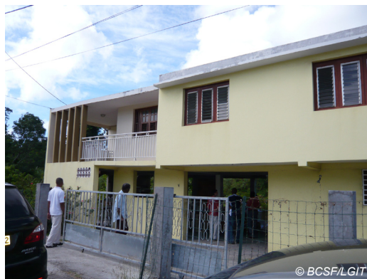
Fig. V 222 : Ferré, Sainte-Anne. La partie avale de la maison a commencé à glisser dans la pente.
