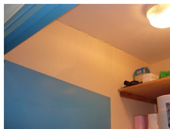
Fig. V-113 : Bellefontaine - crèche - fissure entre mur et dalle.
