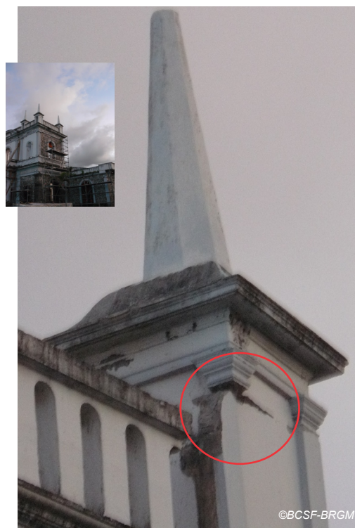
Fig. V-23 : Le Lorrain Eglise de 1743 en cours de restauration.
