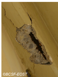
Fig. V-65 : Eclatement de béton sur élément corrodé.
