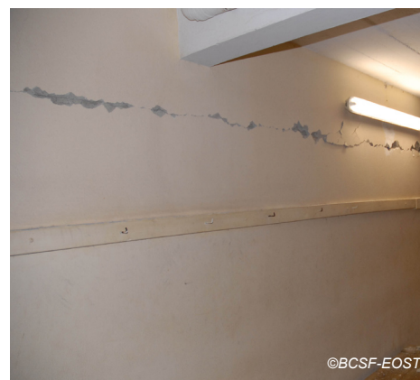
Fig. V-95 : La Trinité - Bâtiment H de l'AFPA - fissure horizontale.
