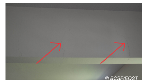
Fig. V-174 : Rivière-Salée, Sécurité sociale - fissures fines induites par la flexion de la poutre.
