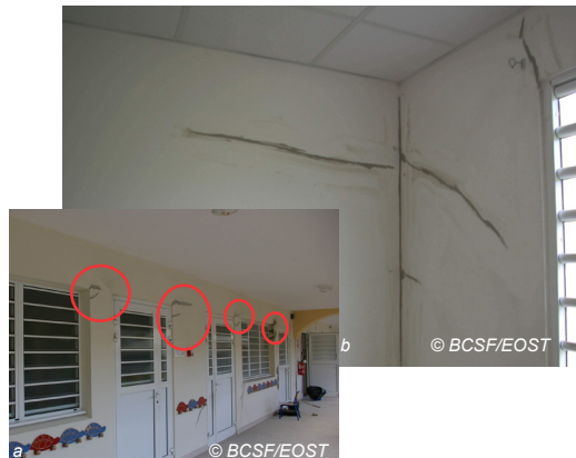
Fig. V-191 : Rivière Pilote - Ecole maternelle Manikou - fissures fines en cours de réparation (murs porteurs).
