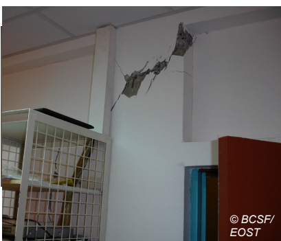
Fig. V-199 : Le Marin, presbytère, rupture d'un poteau.
