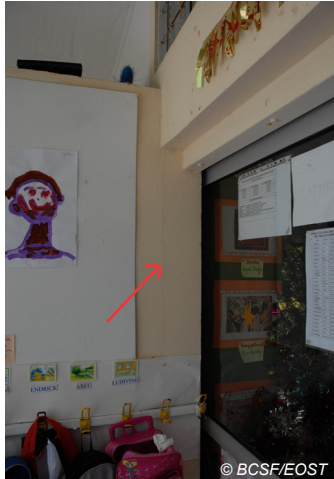
Fig. V-175 : Rivière-Salée - Ecole maternelle de Trénelle - fissure fines.
