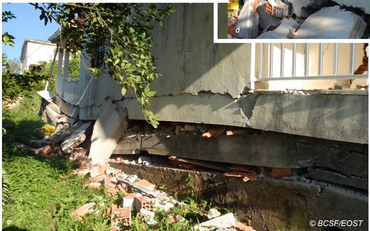
Fig. V-157 : Ducos - Détails de la seule maison individuelle affectée par de forts dégâts à Ducos (dommage de niveau 5) - quartier Saint-Pierre.
