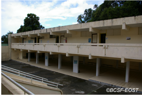
Fig. V-12 : Grand-Rivière - Bâtiment de l'école maternelle (vue générale).
