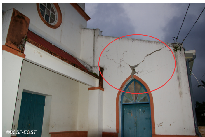
Fig. V-58 : Sainte-Marie, église Mornes des Esses, fissure large et traversante (mur en moellons).
