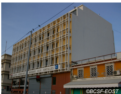
Fig. V-125 : Fort-de-France Immeuble SGBA façade est.
