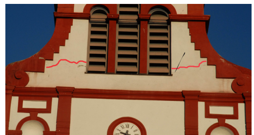
Fig. V-156 : Ducos - Fissuration du clocher de l'église.
