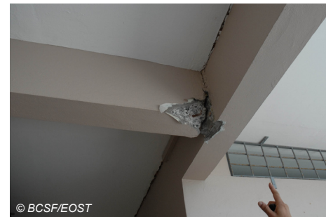
Fig. V-172 : Rivière-Salée - Ecole primaire - dégâts sur partie structurale.
