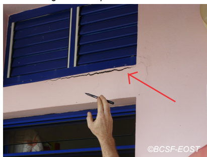
Fig. V-48 : Le Marigot, école primaire de Baignoire fissure sur linteau.
