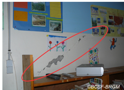
Fig. V-27 : Le Lorrain, école Léon Cécile Carabin, fissure à 45°.
