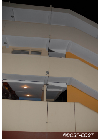
Fig. V-80 : La Trinité, école Auguste Réjon dégât au droit du raccordement de l'escalier.
