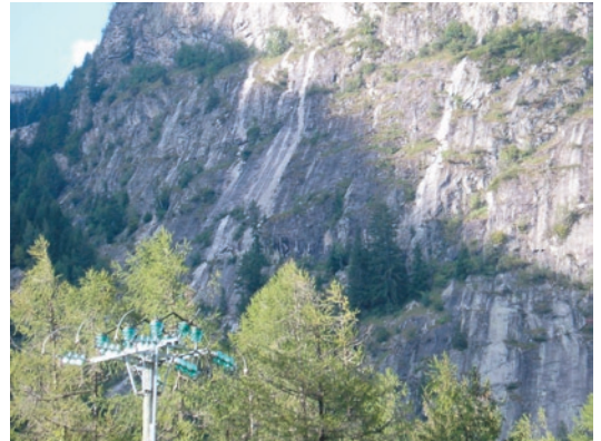
Fig.11 : Traces de chute de pierres dues au séisme (dalles de Barberine où l'alpiniste a été blessée).
