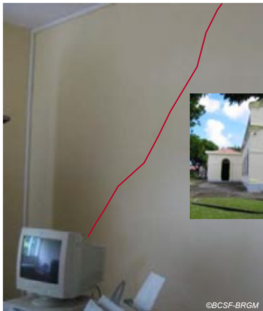
Fig. IV-59. Mairie de Saint-Louis - fissure de niveau 2 en angle de bâtiment.
