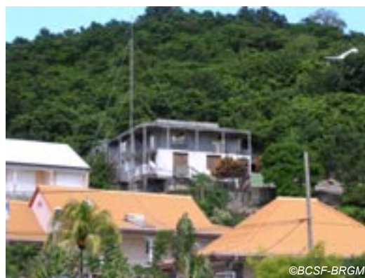
Fig. IV-10. Exemples de constructions de Petites-Anses (proche de la zone la plus affectée) sans dégât apparent.
