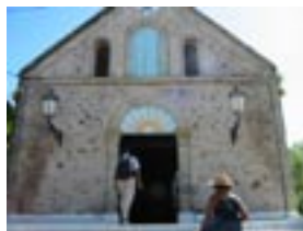
Fig. IV-26. Façade de l'église - sans dégât.
