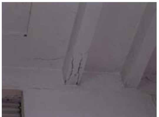
Fig. IV-69. Petit-Bourg - église, fissure sur structure
