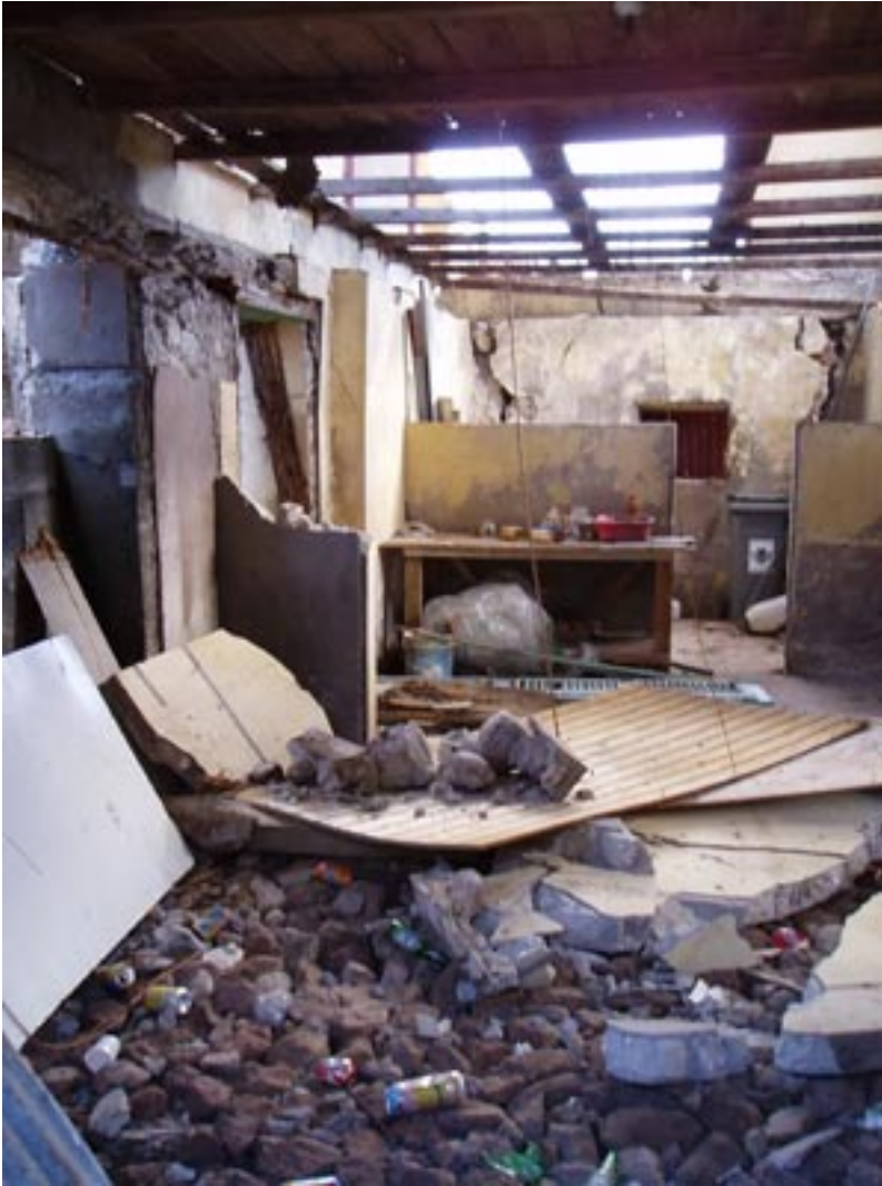
Fig. IV-6. Exemples de constructions en maçonnerie en pierre (moellons) - Terre-de-Bas.
