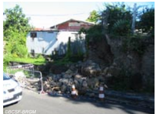
Fig. IV-65. Eboulement d'un mur en partie haute de la commune de Basse-Terre.
