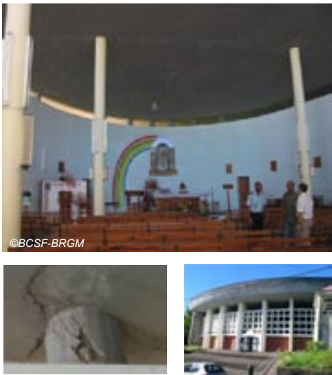
Fig. IV-45. Flambage de piliers sur l'église de Matouba (effets poteaux-courts).
