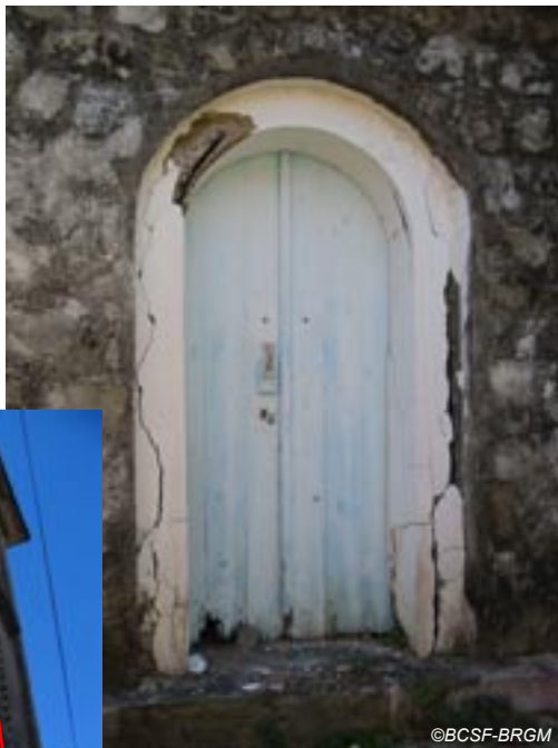
Fig. IV-24. Terre-de-Haut - porte du clocher de l'église.
