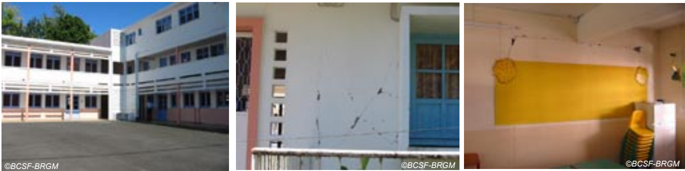
Fig. IV-46. Ecole mixte Louis Chalcol - Entreoquement des corps de bâtiment disposés en L, dégâts de niveau 2 et 3 - vulnérabilité C).
