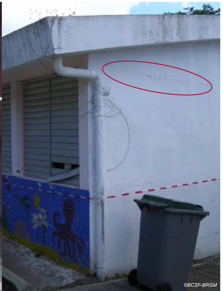
Fig. IV-13. Dommages sur la structure à l'école maternelle de Petites-Anses (vulnérabilité B).
