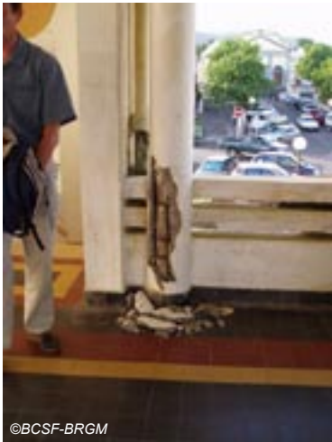
Fig. IV-32. Marché couvert : dommages en tête de poteau, généralisés sur cette structure (dommage de niveau 2-3). On peut suspecter un phénomène de poteaux courts.
