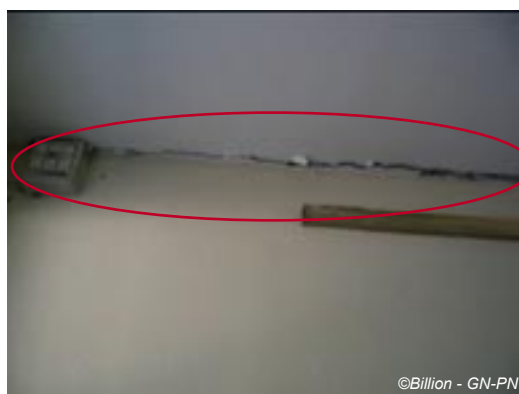
Fig. IV-80. Pointe-Noire - école Acomat, désolidarisation entre le plafond et le mur.
