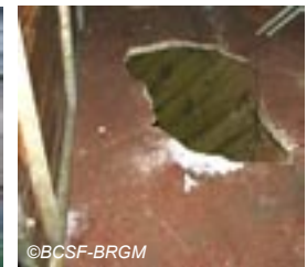
Fig. IV-64. Bâtiment "Ex-Pharmacie" servant d'atelier particulièrement vulnérable et dangereux (pilotis) - Trou dans la dalle du rez-de-chaussée.
