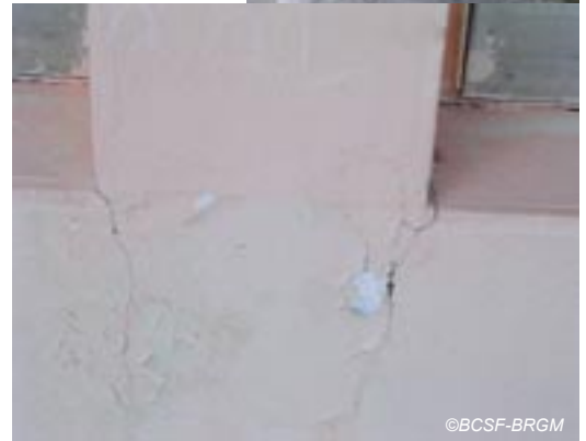
Fig. IV-12. Fissures au collège de Terre-de-Bas. Bâtiment récent, construit selon les normes PS69 (vulnérabilité E).
