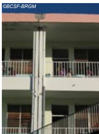
Fig. IV-78. Dégâts au niveau du joint de dilatation.
