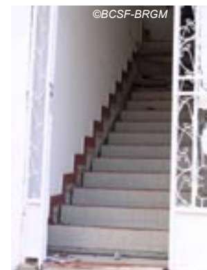
Fig. IV-18. Décrochement de l'escalier de l'hôtel.
