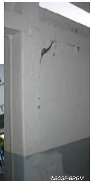
Fig. IV-74. Bouillante - école mixte de Village - fissurations entre le mur de remplissage et la structure .
