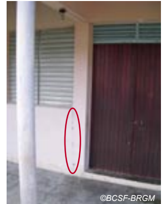
Fig. IV-11. Fissures sur une maison à proximité du débarcadère (vulnérabilité C).
