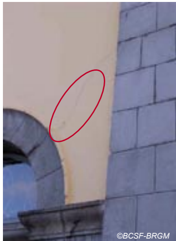
Fig. IV-33. Fissures « symétriques » de part et d'autre du fronton de l'église au centre du bourg (niveau 2).
