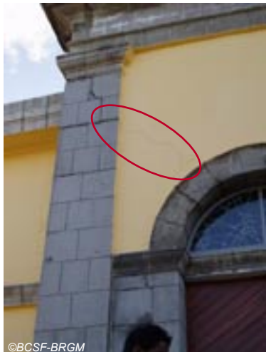
Fig. IV-33. Fissures « symétriques » de part et d'autre du fronton de l'église au centre du bourg (niveau 2).
