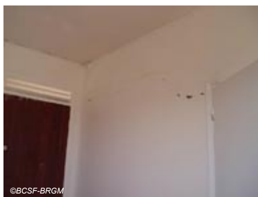
Fig. IV-85. Les seuls dégâts sur l'unique habitation individuelle de Vieux Fort ayant fait l'objet d'une déclaration en mairie relèvent de nombreuses fines fines (intérieures, extérieures), ainsi qu'un dommage sur un élément de toiture.
