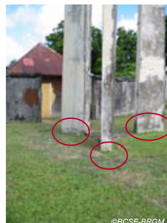
Fig. IV-63. Trépier du clocher de l'église de Saint-Louis - fissuration à la base.
