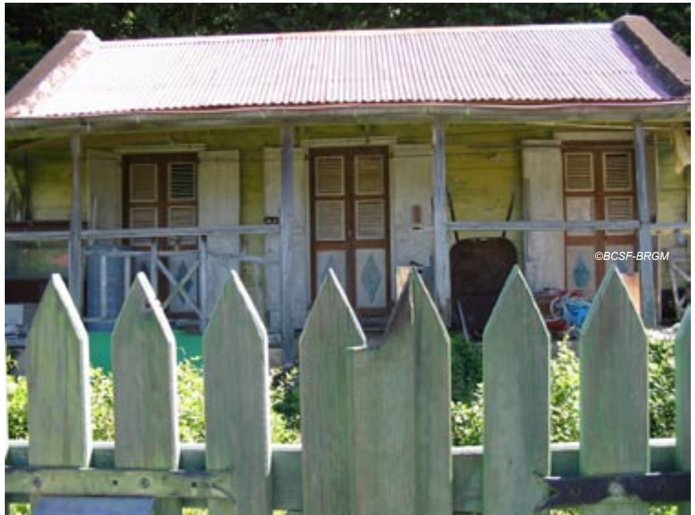
Fig. IV-5. Exemple d'une construction en bois (Terre-de-Haut) au comportement parasismique satisfaisant - Terre-de-Haut.
