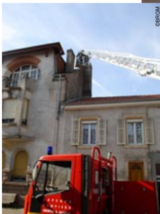
Photo 63 Intervention des pompiers sur une cheminée menaçante
