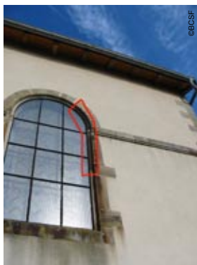
Photo 73 - Endommagement de joints de fenêtres de protec- tion
