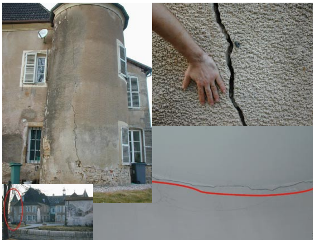
Photo 111 - Girecourt - Château - Elargissement d'une fissure pré-existante
