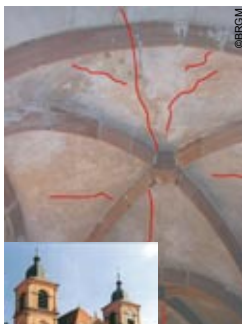
Photo 94 - Fissure sur voûte du cloître de la Cathédrale de St-Dié
