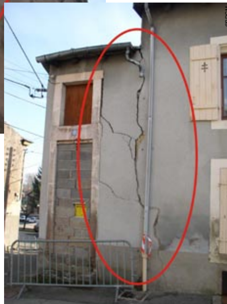
Photo 65 - Dégâts structuraux verticaux de degré 3
