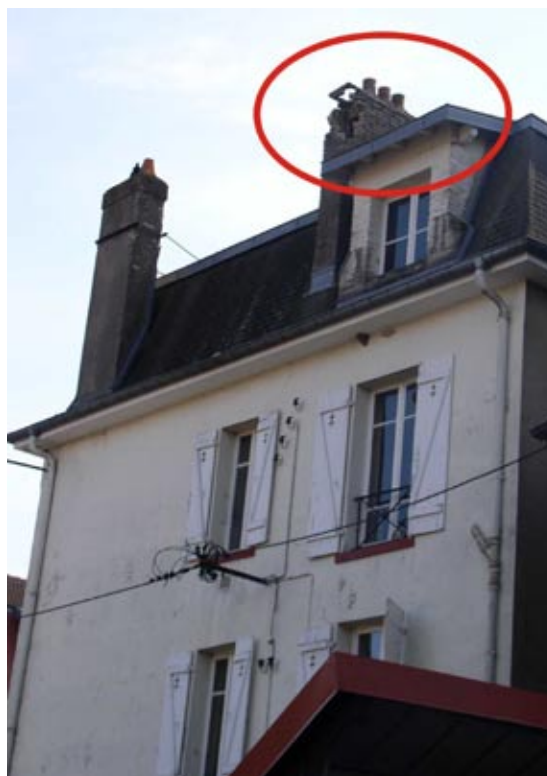
Photo 67 - Désordre sur cheminée.
