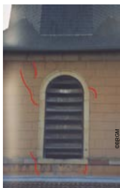
Photo 112 - Girecourt - Clocher de l'église
