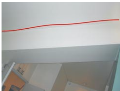
Photo 99 - Espace Georges Sadoul poutre fissurée (salle repeinte récemment)
