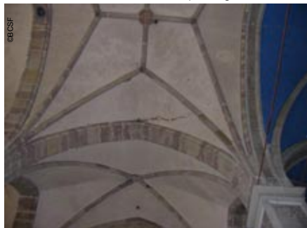
Photo 50 - Fissuration large sur le remplissage de la voûte
