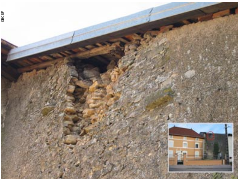
Photo 23 Destord Ouverture de portes, chutes et bris d'objets
