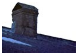
Photo 102 - Grandvillers (dép. 88) - Fissure sur cheminée
