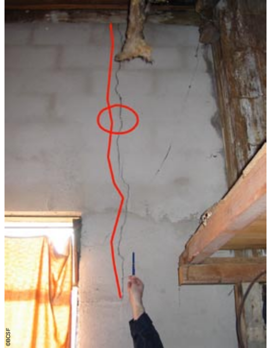
Photo 39 - Rambervillers (départ.88) - Fissuration large de part en part d'un mur porteur en aggro.
