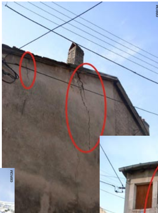
Photo 62 - Baccarat (Dép.54) Fissuration large sur mur extérieur
