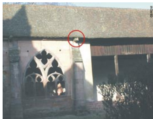
Photo 94 - Fissure sur voûte du cloître de la Cathédrale de St-Dié
