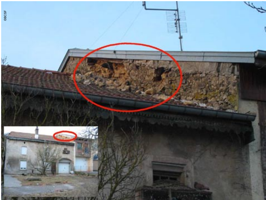
Photo 10 Sainte-Hélène (départ.88) Défaillance d'un mur en moellons brutes considéré comme un dégât de degré 4 sur l'EMS98 .
