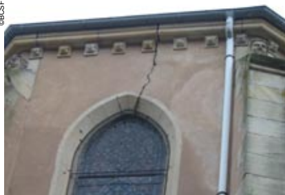
Photo 103 - Grandvillers Eglise Agrandissement de fissure.
