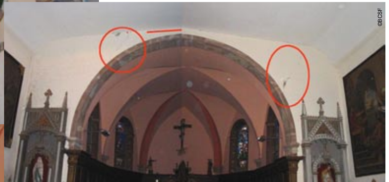
Photo 17 Sainte-Hélène Fissuration au niveau du toit de la nef et de l'arc principal.
