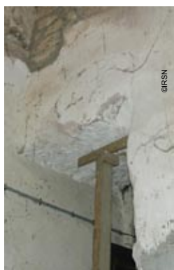
Photo 104 - Intérieur du clocher d'Housseras - Formation de fissures qui nécessitent l'installation d'une poutre en prévention d'un effondrement.
