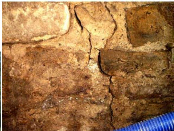
Photo 116 - Bains-les-Bains - Intensité IV-V (dép.88 - 35 km de l'épicentre) Fissurations sur maison particulière, atteignant les fondations selon le propriétaire (sans visite BCSF - images envoyées par le propriétaire)
