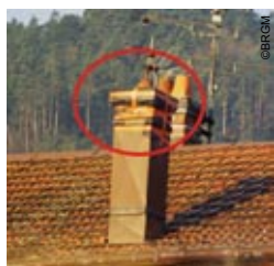
Photo 92 - Saint-Dié (départ. 88) Endommagement de chapeau de cheminée
