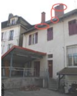
Photo 61 - Baccarat (Dép.54) Endommagement de cheminées
