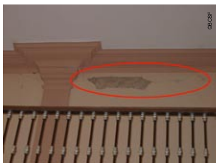
Photo 74 - Eclatement de plâtre sur le mur entre la nef et le clocher
