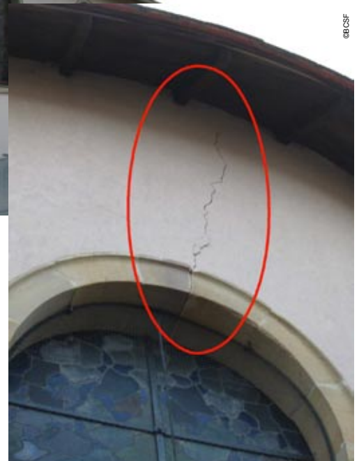
Photo 70 - Fissures fines sur ouverture de la nef
