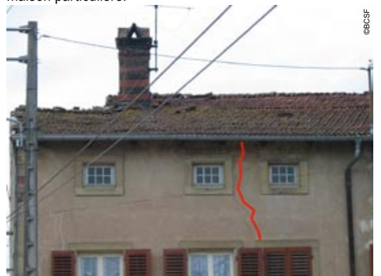
Photo 41 - Rambervillers (départ.88) - Fissuration légère sur maison particulière.
