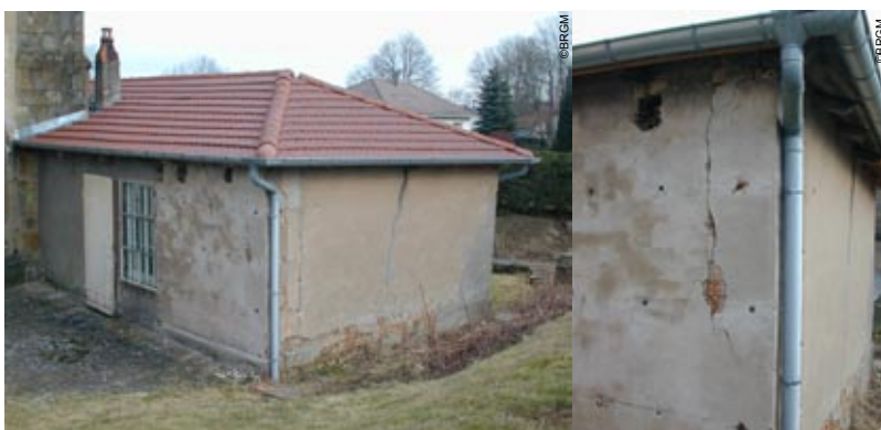
Photo 109 - Eglise de Aydoilles - Bâtiment annexe fissuré
