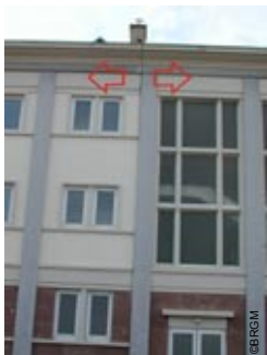
Photo 97 - Ecartement d'un joint de dilatation sur bâtiment en béton armé
