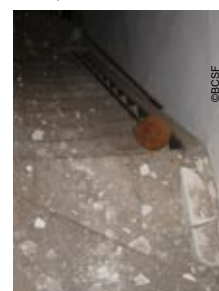
Photo 18 Sainte-Hélène (départ. 88) Chute de petits morceaux de plâtre à proximité du clocher
