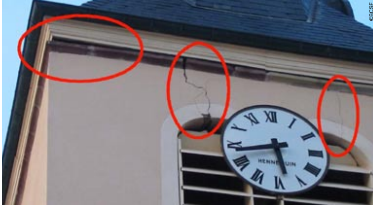
Photo 14 Sainte-Hélène (départ. 88) Fissuration du clocher de l'église et effet de plateau sur la toiture.
