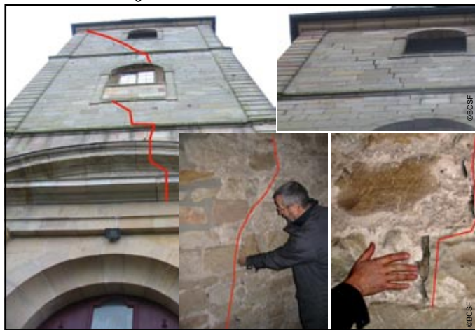
Photo 58 - Chaînage du haut du clocher ayant maintenu la structure
