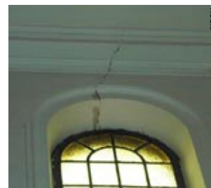
Photo 105 - Eglise de Housseras Fissure sur arc de voûte
