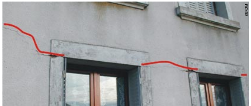
Photo 89 - Dompierre - fissure fine sur maison
