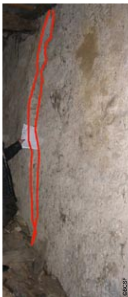
Photo 75 Agrandissement d'une déformation de mur en moellons. La partie extérieure mitoyenne s'est effondrée dans une chambre à coucher.
