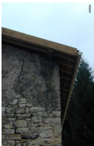
Photo 35 - Frémifontaine (dép.88) Maison évacuée, exemple de fissure sur un coin
