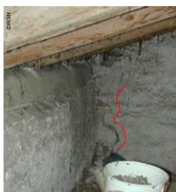
Photo 84 - Pierrepont-sur-l'Arentèle Lézarde se retrouvant sous la toiture.
