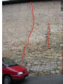
Photo 54 - Fissuration sur ancienne ouverture
