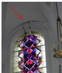
Photo 79 - Pierrepont-sur-l'Arentèle (départ. 54) Affaissement de la clef de voûte
