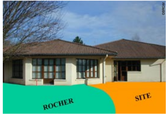
Photo 106 - Aydoilles (dép.88) - Ecole maternelle récente (1987) se trouvant sur un contact rocher / site présentant plusieurs fissures liées au séisme (margelles, bitume extérieur, carrelage intérieur, murs intérieurs et extérieurs)
