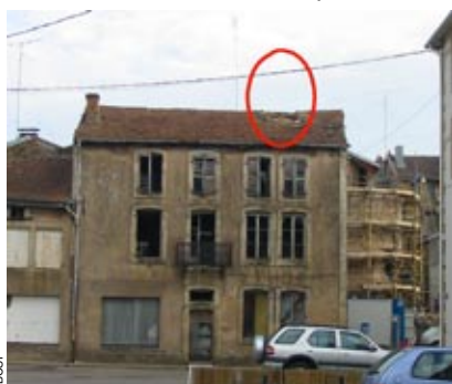
Photo 42 - Rambervillers (départ.88) - Chute de cheminée sur bâtiment en mauvais état.
