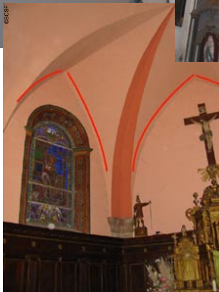
Photo 18 Sainte-Hélène (départ. 88) Chute de petits morceaux de plâtre à proximité du clocher
