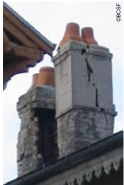
Photo 38 - Rambervillers (départ.88) - Fissuration large et éroulement partiel de cheminées.
