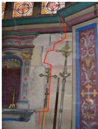
Photo 46 - Large agrandissement d'une fissure derrière l'autel.
