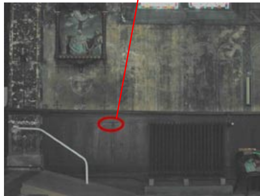
Photo 98 - Eglise jouxtant le centre de cure médicale de long séjour de Foucharupt, boiseries compressées et écaillées
