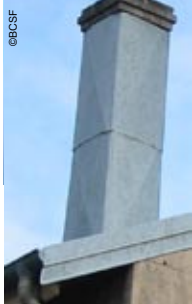
Photo 15 Exemple d'un chemisage en acier galvanisé ayant protégé de nombreux éléments de ce type sur la région.
