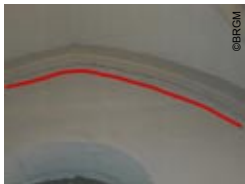
Photo 107 - Eglise de Aydoilles - Fissuration au raccordement des tympans avec la voûte de l'église.
