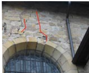
Photo 53 - Agrandissement de fissures existantes
