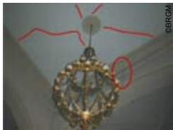
Photo 108 - Eglise de Aydoilles - Fissuration du plafond en étoile.
