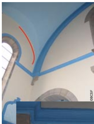
Photo 75 Agrandissement d'une déformation de mur en moellons. La partie extérieure mitoyenne s'est effondrée dans une chambre à coucher.
