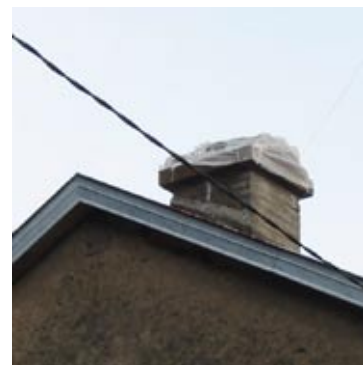
Photo 78 - Saint-Benoît-la-Chipotte Chute de chapeau de cheminée
