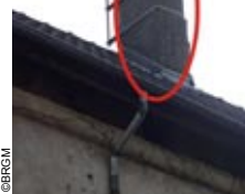
Photo 57 Désordre de cheminée
