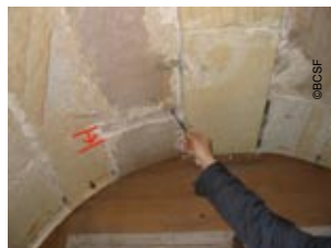
Photo 59 Affaissement d'une clef de voûte
