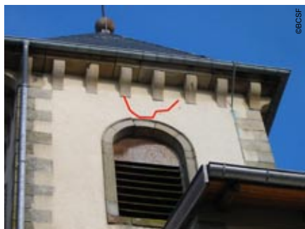
Photo 72 - Saint-Genest (département 88) Fissure et décalage de clef de voûte sur le clocher de l'église
