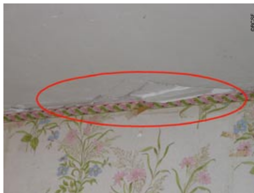
Photo 29 - Jeanménil Lieu-dit Larifontaine - fissuration entre mur et plafond
