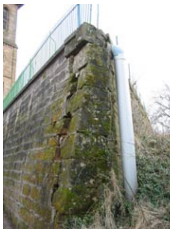
Photo 77 Saint-Benoît-la-Chipotte (dép.88) Agrandissement d'un décalage d'angle sur le mur montant à l'église.
