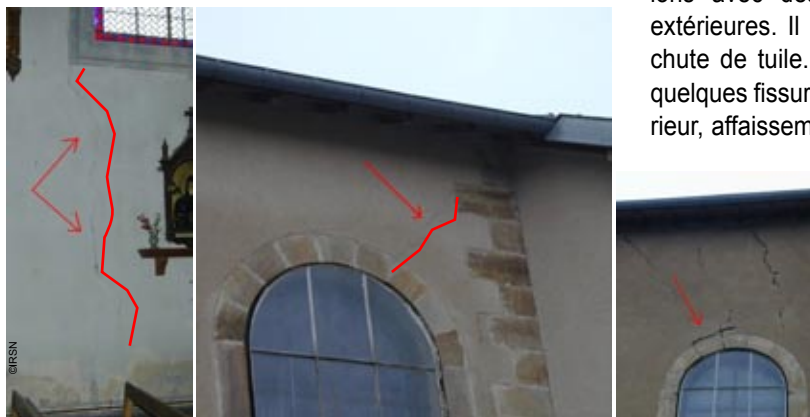
Photo 80 - Pierrepont-sur l'Arentèle Fissures intérieures et extérieures sur l'église
