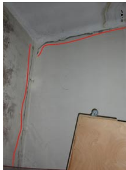
Photo 100 - Espace Georges Sadoul Fissuration aux angles de murs
