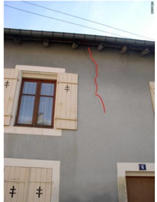
Photo 66 - Fissuration large sur mur extérieur
