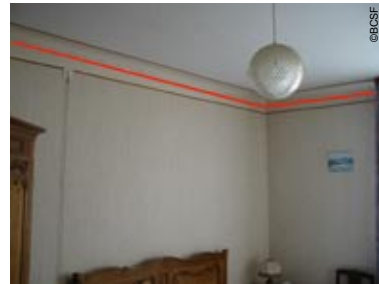
Photo 22 Destord Fissuration large sur raccord en plâtre entre le mur et le plafond (1 er étage - maison en moellons)
