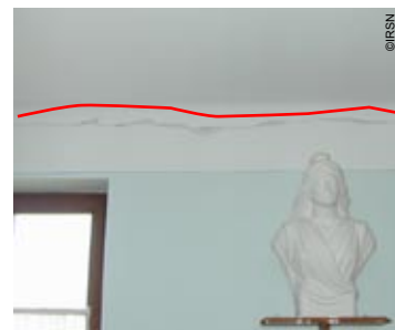
Photo 82 - Pierrepont-sur-l'Arentèle Fissure au raccord plafond et mur
