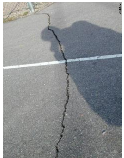
Photo 110 - Aydoilles Ecole maternelle - fissuration du bitume à l'angle de mur.
