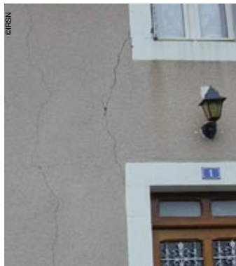
Photo 34 Frémifontaine (dép88) Fissure extérieure fine sur bâtiment
