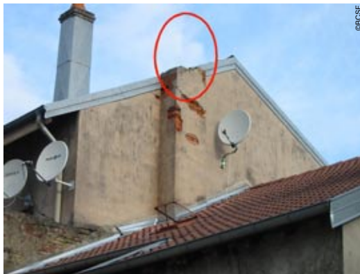
Photo 37 - Rambervillers (départ.88) - Chute d'une cheminée non chemisée.
