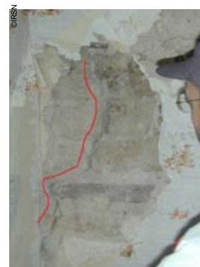
Photo 83 - Pierrepont-sur-l'Arentèle - Lézarde dans le logement au 1er étage de la mairie.
