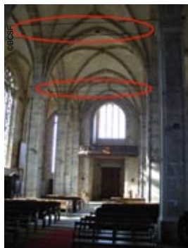
Photo 49 - Tiges d'acier de renforcement des voûtes
