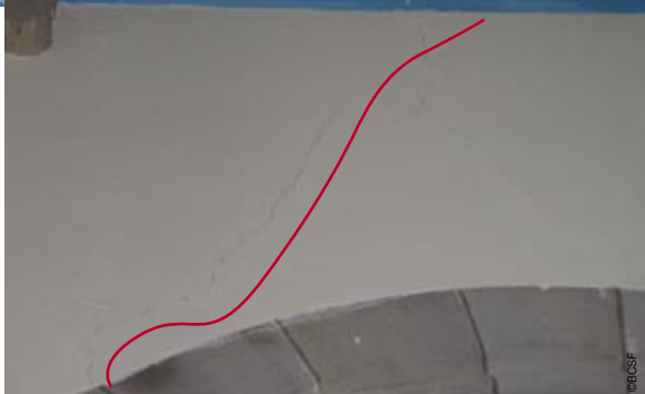
Photo 76 - Saint-Gorgon Fissures fines et décollement de crépis sur l'église
