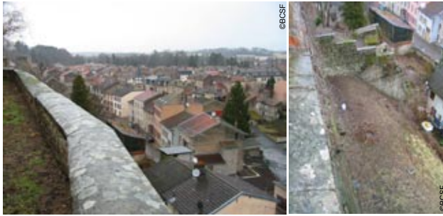
Photo 51 Deneuvre (départ.54) Vue panoramique du presbytère et hauteur du surplomb.
