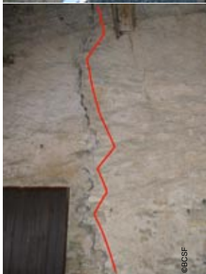
Photo 71 - Fissures large sur mur porteur à l'intérieur d'une grange
