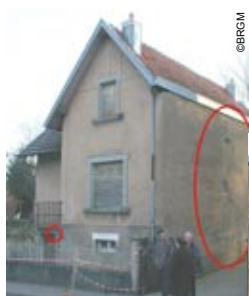
Photo 93 - Fissure sur bâtiment ancien (arrêté de mise en péril)
