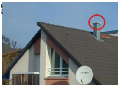
Photo 101 - Chute de chapeau de cheminée sur maison récente
