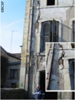
Photo 36 - Rambervillers (départ.88) - Elargissement d'une fissuration sur bâtiment en cours de démolition.
