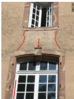
Photo 44 - Façade sud, corps du bâtiment
