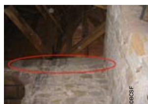
Photo 58 - Chaînage du haut du clocher ayant maintenu la structure
