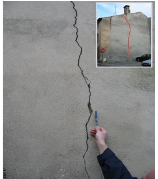
Photo 40 - Rambervillers (départ.88) - Fissuration large, vraisemblablement due à un effet de "claquage" sur le crépis.
