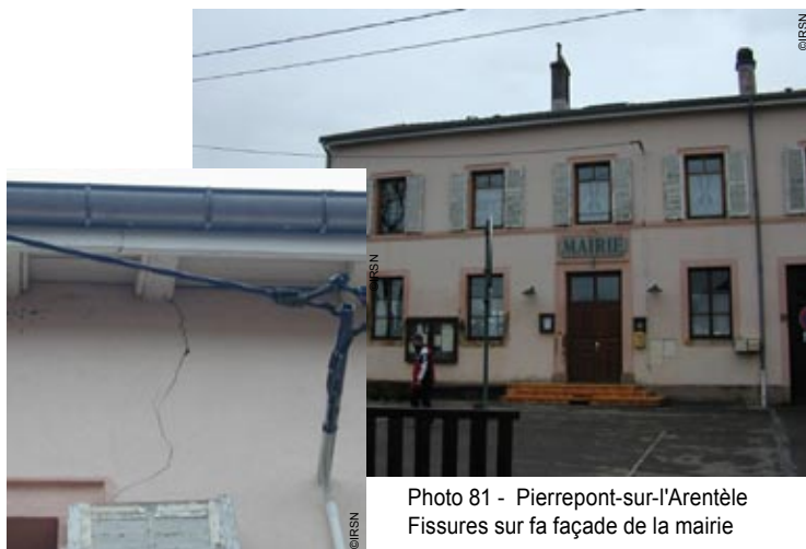
Photo 82 - Pierrepont-sur-l'Arentèle Fissure au raccord plafond et mur
