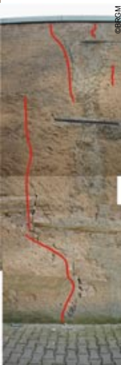
Photo 93 - Fissure sur bâtiment ancien (arrêté de mise en péril)
