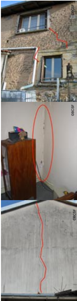
Photo 28 - Jeanménil Lieu-dit Larifontaine - fissuration généralisée sur bâtiment de vulnérabilité A .
