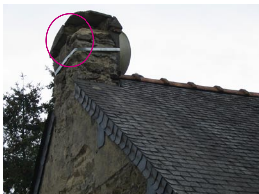
Fig.10 - Chute d'une partie de couronne de cheminée (Hennebont, rue du Meunier).
