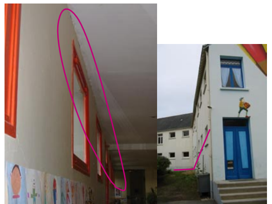
Fig.14 - Fissure entre dalle et mur extérieur (Ecole Notre Dame du Vœu, Hennebont).
