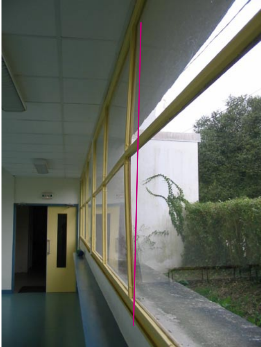
Fig.35 - Cintrage de la structure de la fenêtre (Ecole Bilingue - Lorient)
