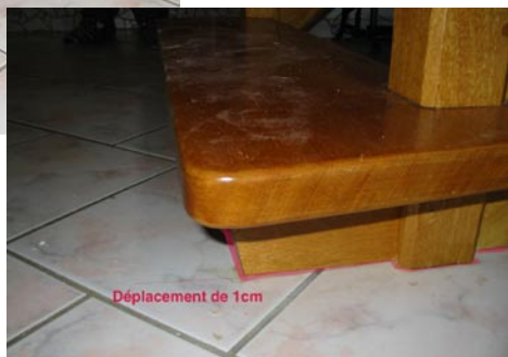
Fig.15 Déplacement de l'escalier non fixé au sol (Hennebont, rue du Meunier).
