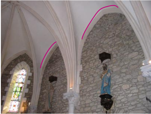
Fig.27 - fissures sur arc de voûte (église de Grand-Champ)
