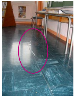
Fig.34 - Fissures sur sol par affaissement (Ecole Bois-Bissonnet - Lorient)
