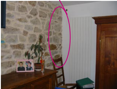
Fig.12 - Fissure fine (rue du Meunier - Hennebont)
