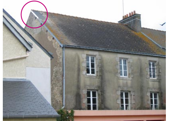
Fig.11 - Ebranlement d'une cheminée (Hennebont Ecole Ntre.Dame du Vœu).
