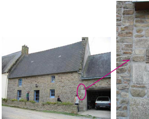
Fig.22 - très légère fissure entre les deux bâtiments (Kerhen-Liven, Languidic)
