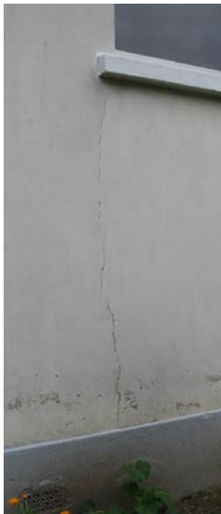
Fig.17 - Fissure sur mur extérieur - façade ouest (Ecole Notre Dame du Voeu, Hennebont).
