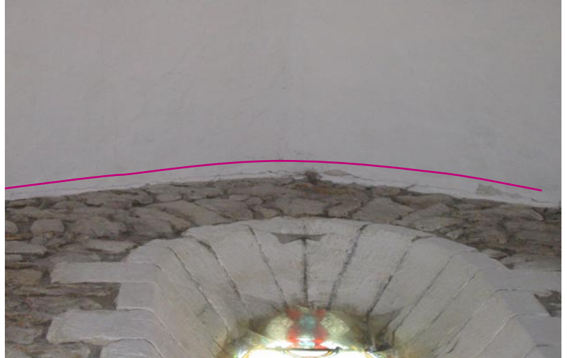
Fig.28 - fissures sur plafond de voûte (église de Grand-Champ)
