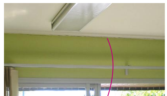
Fig.25 - fissures entre mur extérieur et dalle de plafond (restaurant scolaire Grand-Champ)
