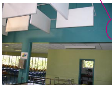
Fig.24 - fissures sur poutre de soutien (restaurant scolaire Grand-Champ)
