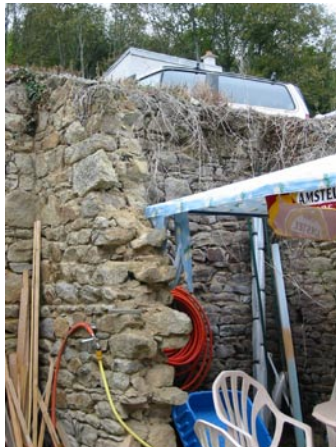
Fig.13 - Chute de pierres d'un mur en mauvais état (rue du Meunier - Hennebont)
