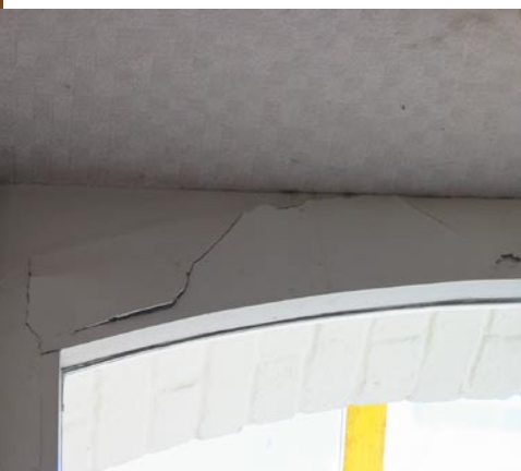
Fig.19 - Eclatement de peinture - façade est (Inzinzac-Lochrist, mairie).
