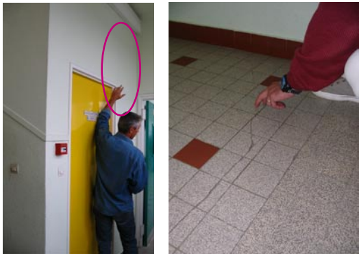
Fig.32 - Fissures sur sol et murs (Lycée Colbert - Lorient)
